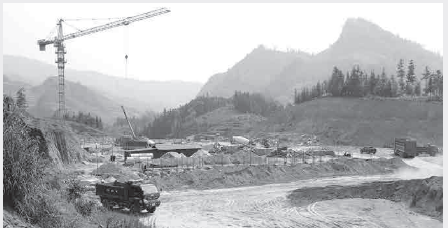
Công trường xây dựng Bệnh viện Đa khoa Bắc Hà
