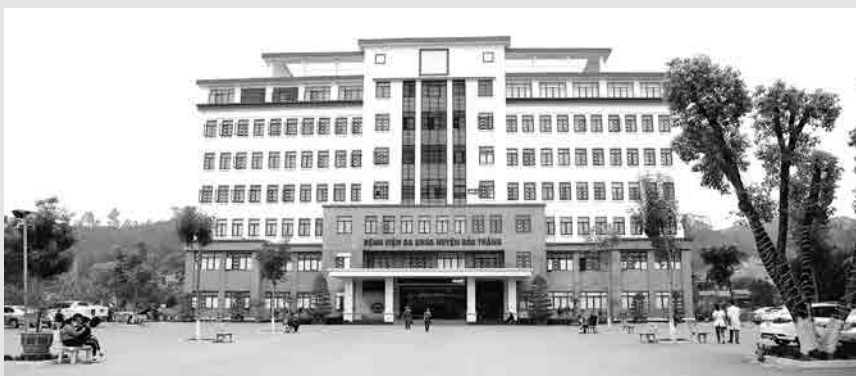
Khu nhà 07 tầng mới được đưa vào sử dụng của Bệnh viện Đa khoa huyện Bảo Thắng
