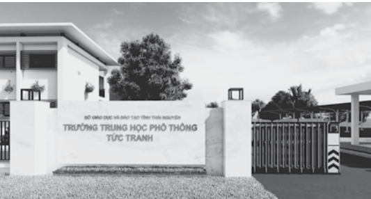
Phối cảnh Trường THPT Tức Tranh, huyện Phú Lương đang được đẩy nhanh tiến độ đầu tư, hoàn thành nốt các hạng mục còn lại để kịp đón học sinh năm học mới 2023-2024.
