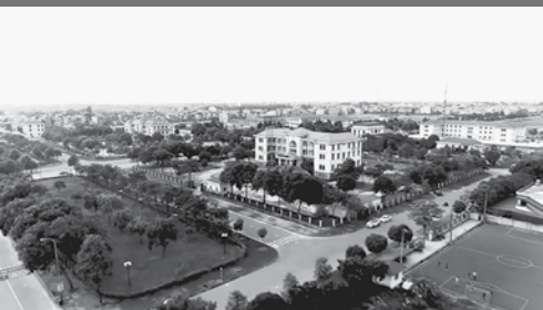
Cơ sở hạ tầng được đầu tư đồng bộ, góp phần thúc đẩy phát triển lĩnh vực công nghiệp, đô thị, mang lại diện mạo mới cho địa phương
